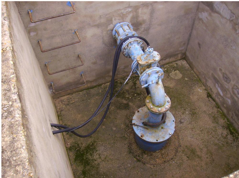
***Detalle sondeo nº10 (el borde del emboquille está a un metro por debajo de la superficie del suelo).***
